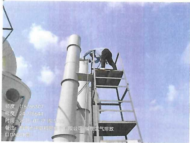
碱性废气排放口 DA001: 氨
