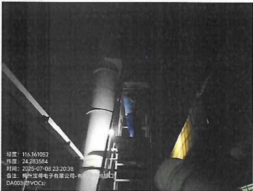
有机废气排放口 DA003: 总 VOCs
