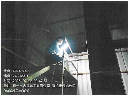
有机废气排放口 DA002: 总 VOCs
