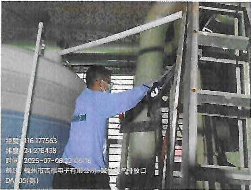
碱性废气排放口 DA005: 氨
