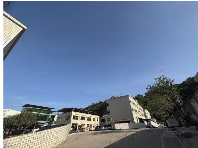
项目南面（梅州市邦源环保科技有限公司闲置办公楼、仓库）
