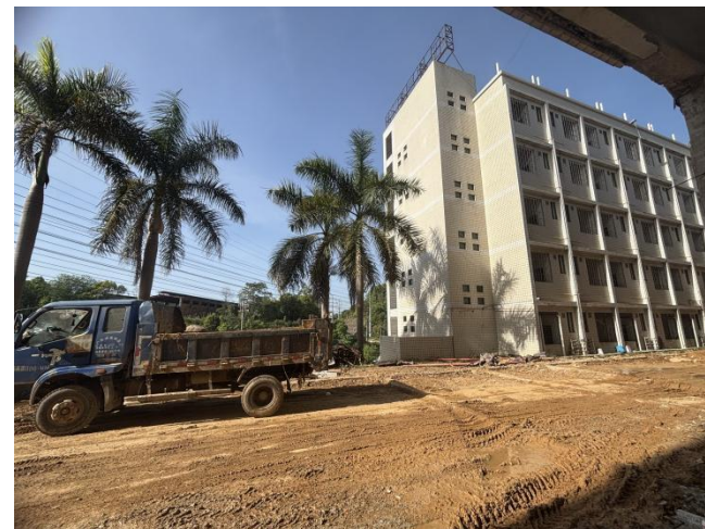
项目北面（梅州市邦源环保科技有限公司闲置宿舍、S333 省道）
