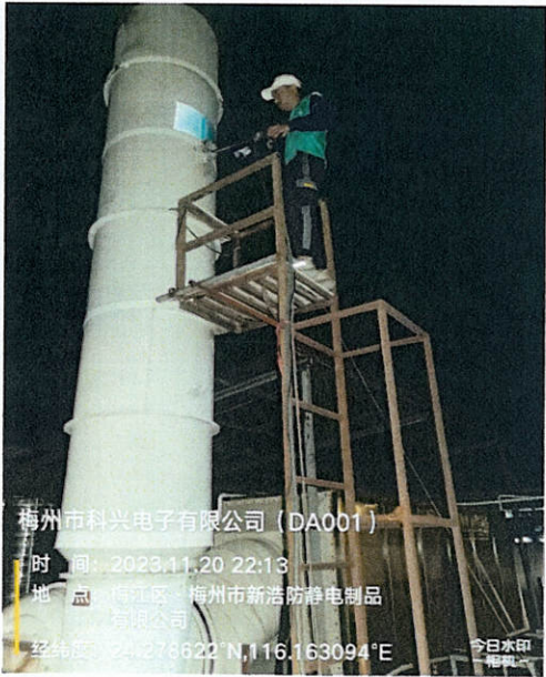
喷锡废气排放口 DA001
