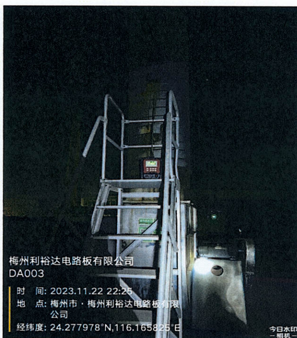
丝印废气排放口 DA003
