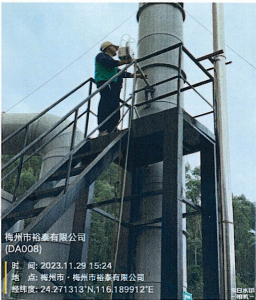
爬坡线废气排放口 DA008
