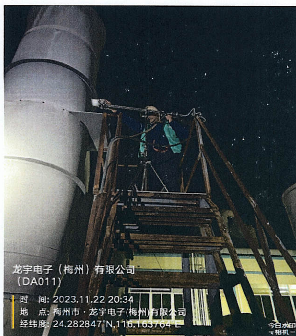
蚀刻、棕化线废气排放口 DA011
