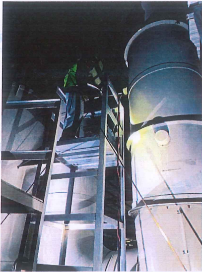
电镀车间废气处理后排放口 DA009
