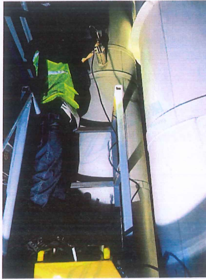
三层碱性蚀刻线废气处理后排 放口 DA004
