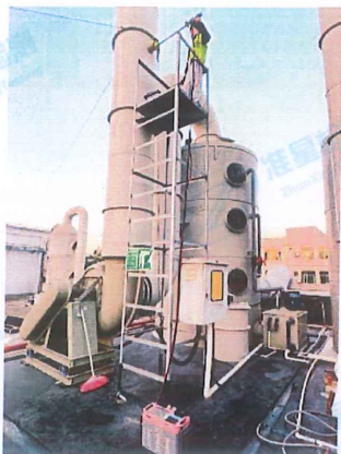
电镀废气处理后排放口 DA008
