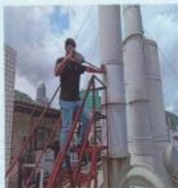
DA006 废气排放口
