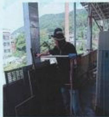
DA010 废气排放口
